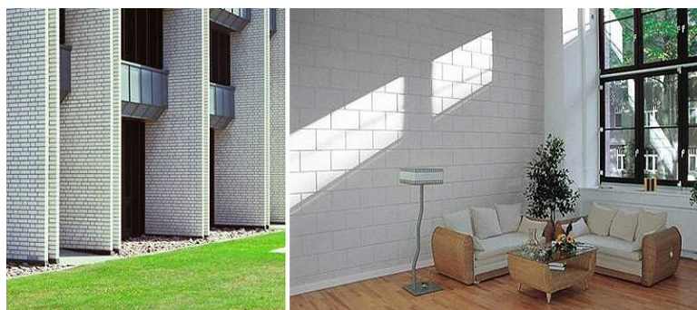
Abbildung 1: Kalksandsteine im Bauwesen; links: Berufsschule in Garbsen; rechts: gestrichene Kalksandsteinwand eines Wohnbereichs
