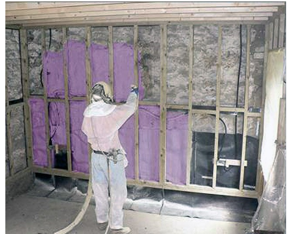
Abbildung 12: Walltite Sprühschaum zur Wärmedämmung
