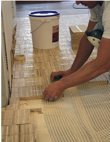
Abbildung 2: Typische Haltung der Fingerkuppen beim Verlegen von Parkett
