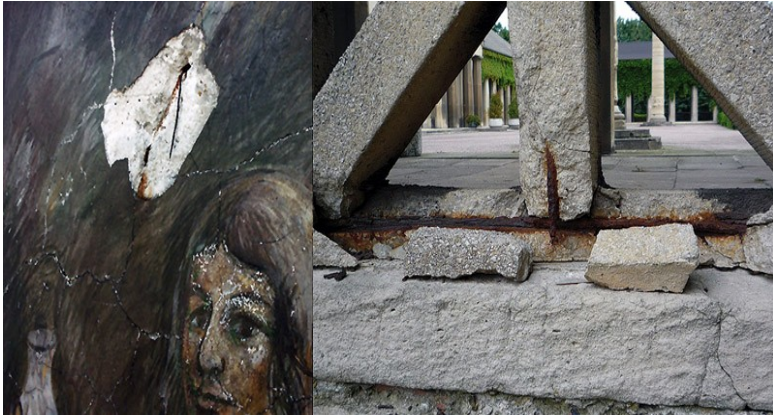
Abbildung 1: Bewehrungskorrosion -
