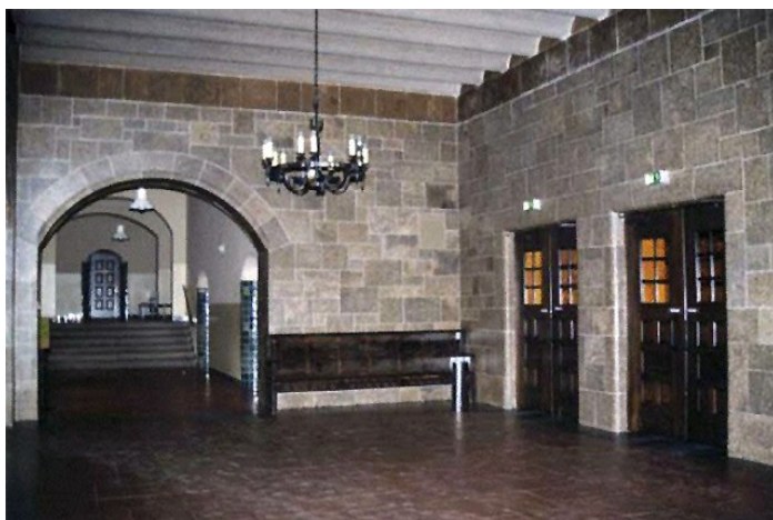
Abbildung 1: Rötgipsplatten des ehemaligen Jenaer Schlosses (1659 – 1662) wurden als Wandverkleidung im Universitätshauptgebäude Jena (1905 – 1908) genutzt (Quelle: C. Haaßengier. – Dissertation. – Weimar 2006)
