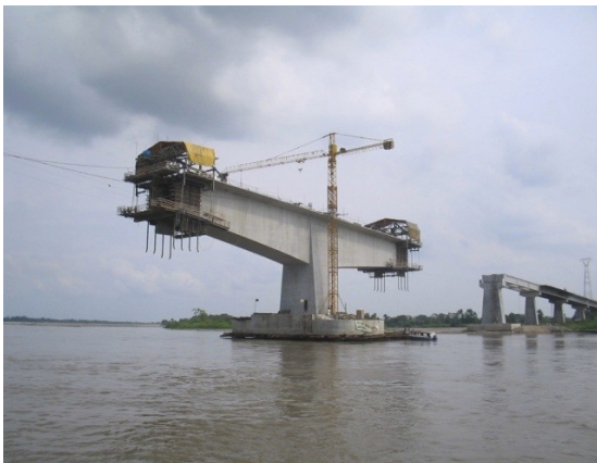
Abbildung 6: Bau einer Betonbrücke
