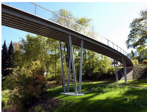
Abbildung 1: Textilbetonbrücke Lautlingen – schlankste Fußgängerbrücke aus Beton. Foto: Sebastian Wochner GmbH & Co.KG
