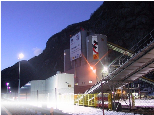
Abbildung 1: Betonanlage am Südportal des Gotthard-Basistunnels in Bodio (Tessin)
