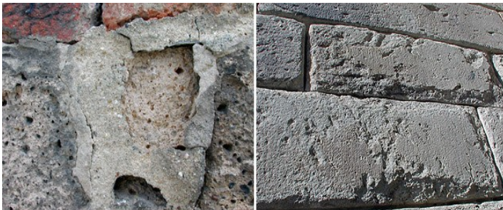
Abbildungen 2 und 3: Herauspräparieren der Fuge (links) und Aufschieben der Flankenzone (rechts)
