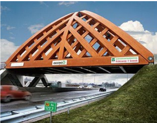
Abbildung 3: Brückenbauwerk in Sneek/NL
