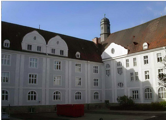
Abbildung 6: Fenster, Landratsamt Würzburg
