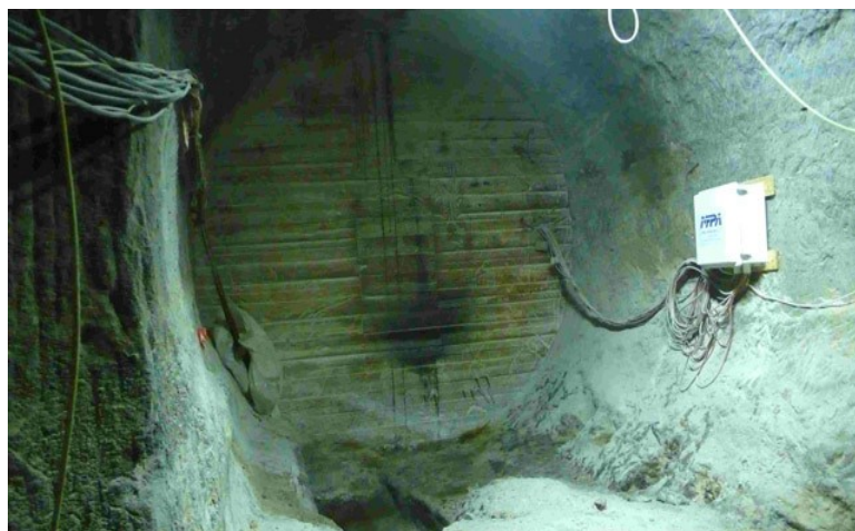
Abbildung 3: Streckenverschluss aus Sorelbeton (MgO-Beton) im Salinar
