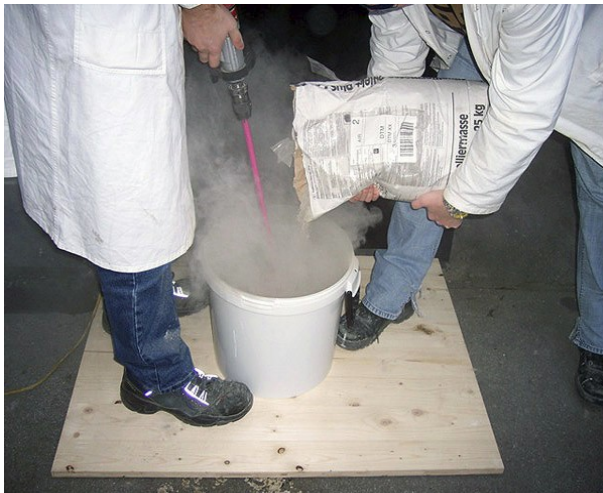
Abbildung 3: Anmischen eines normalen Fliesenklebers
