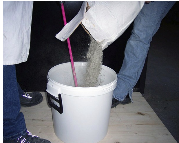
Abbildung 4: Anmischen eines staubreduzierten Produktes
