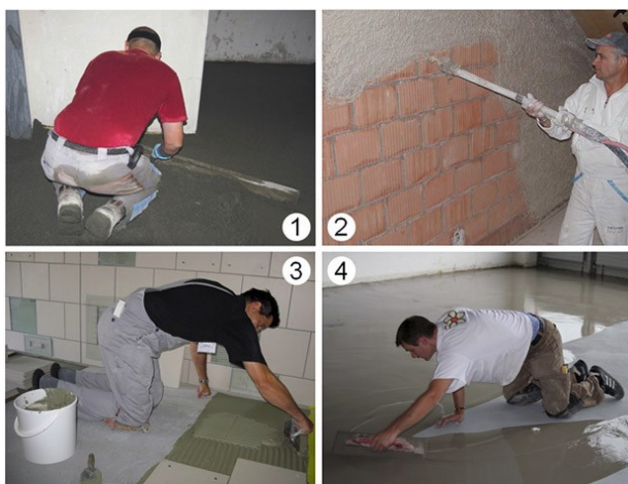
Abbildung 1: Estrich (1), Grundputz (2), Fliesenkleber (3), Bodenspachtelmasse (4).
